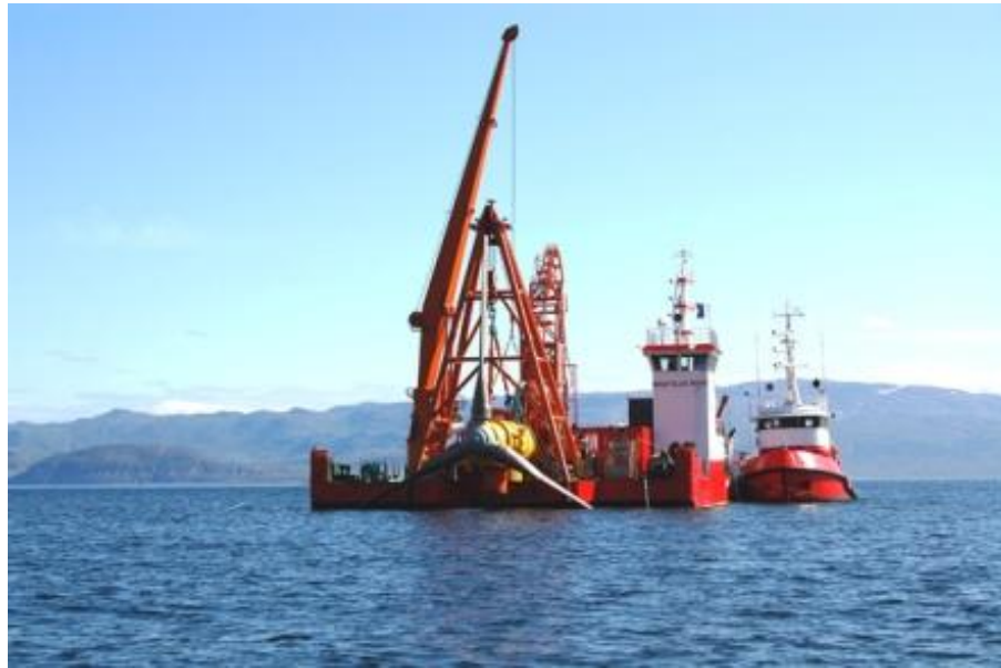
Figura 1-9: Instalación de Turbina Kvalsundet (Tidal energy, s.f.)
