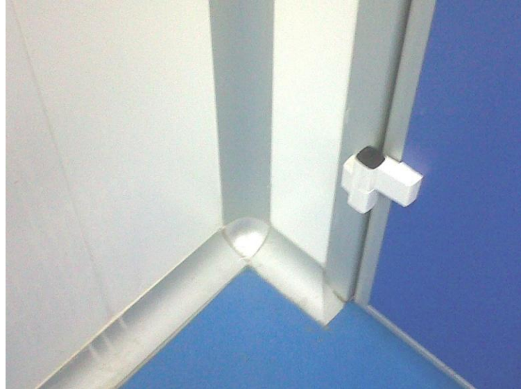
Foto 4.23: Acabado piso panel. Fuente: Investigador (2010).
