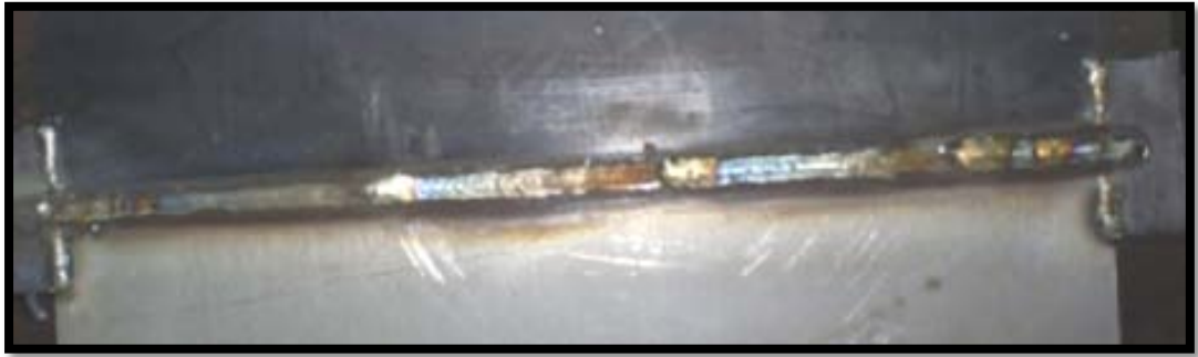
Fig. 3.11. Cordón soldadura depositado con el proceso SMAW.
