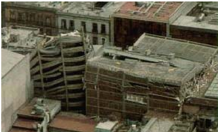
Fotografía IV.9: Falla por Entrepiso Débil ( http://www.ssn.unam.mx/SSN/Doc/Sismo85/Fotos/f1.htm )
