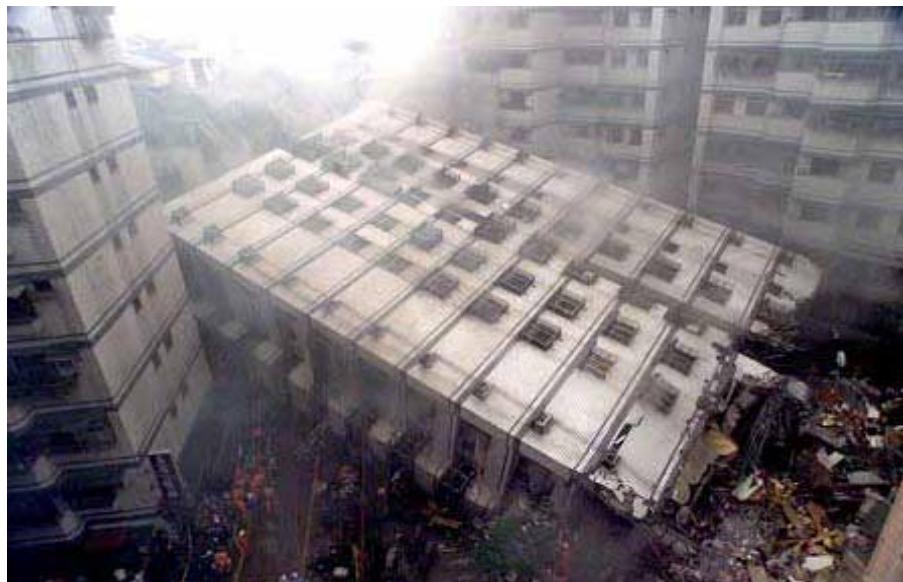
Fotografía IV.13: Colapso por Volcamiento ( http://nisee.berkeley.edu/eqiis_earthquakes.html )
