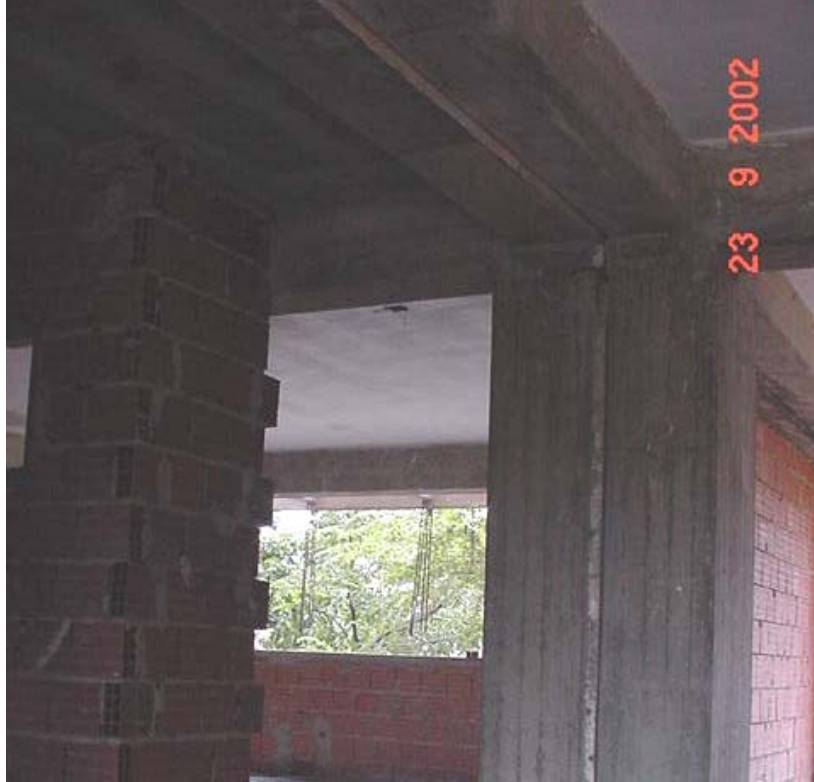
Fotografía VI.4: Junta en el Nivel 3
