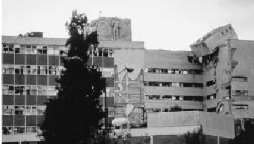
Fotografía IV.2: Concentraciones de Masa en Niveles Superiores, tales como Tanques de Agua en el techo de una estructura, pueden ocasionar graves daños. ( http://165.158.1.110/spanish/ped/mit3-capitulo2.pdf )
