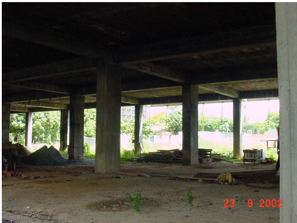
Fotografía VI.15: Pórtico 4 (Planta Baja)
