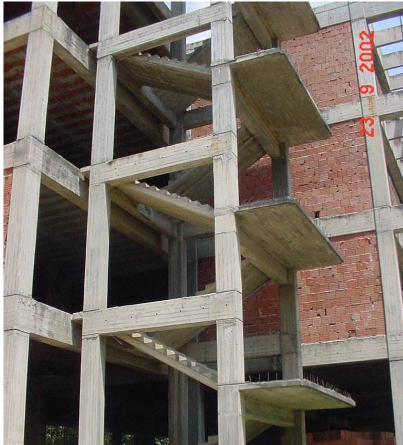
Fotografía VI.5: Escaleras Como Cuerpo Independiente de la Estructura
