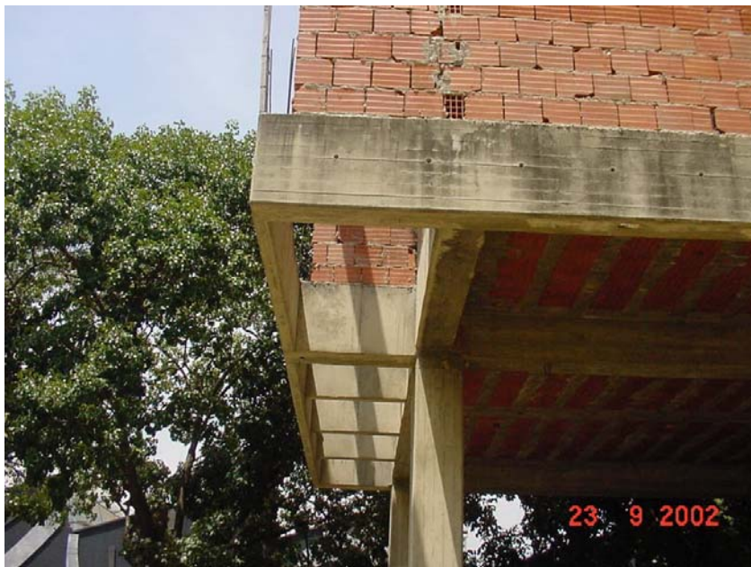
Fotografía VI.10: Voladizo en Pórtico 1
