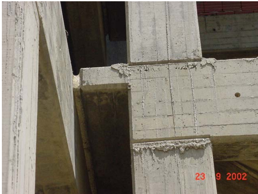
Fotografía VI.6: Detalle de la Junta entre la Edificación y la Escalera
