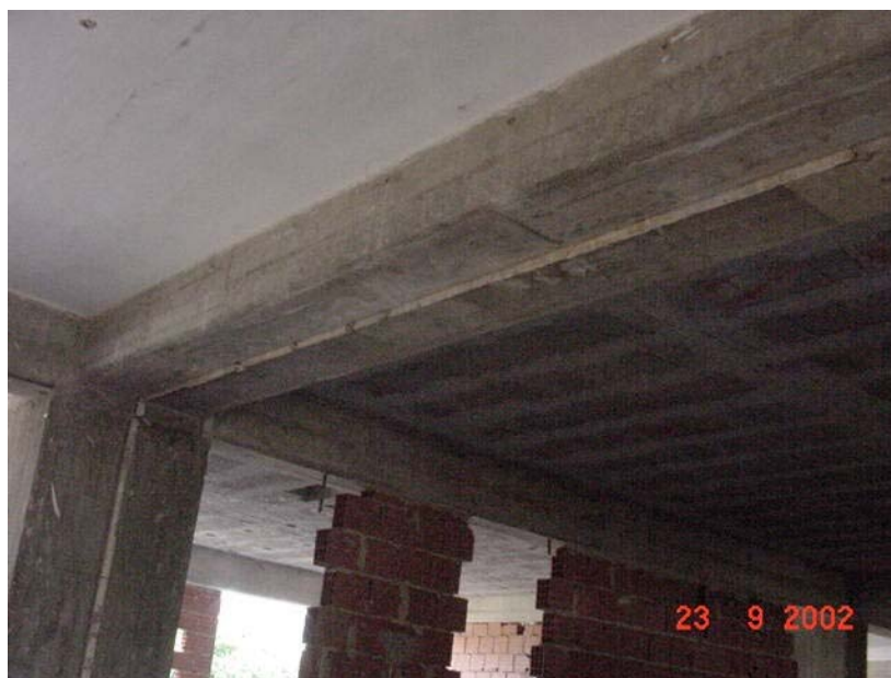
Fotografía VI.3: Junta en el Nivel 3
