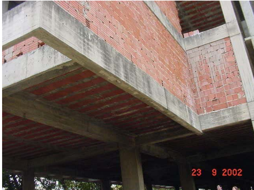
Fotografía VI.9: Voladizo con Viga Auxiliar
