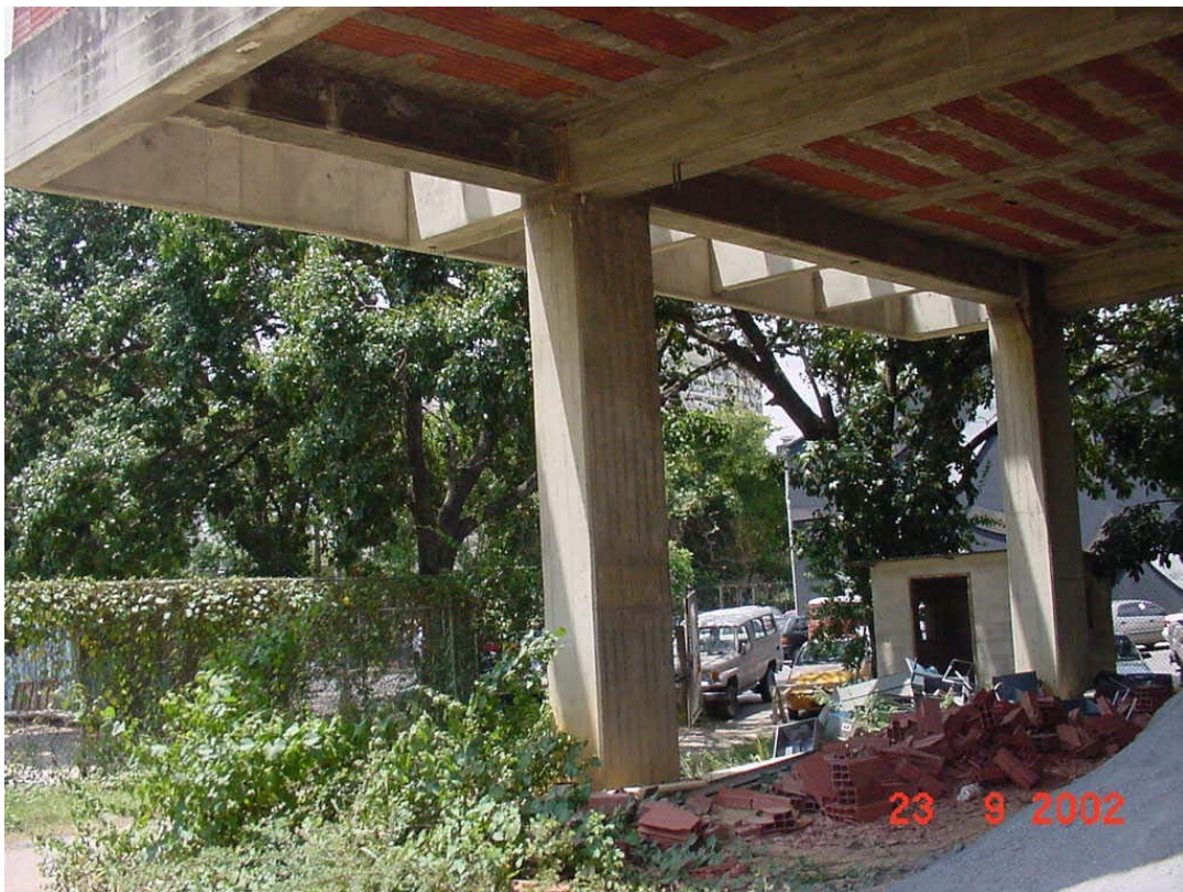
Fotografía VI.13: Vista del Pórtico 1 en la Planta Baja
