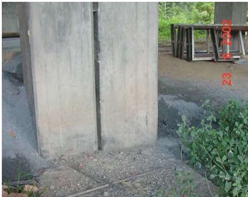
Fotografía VI.2: Junta en Columna de Planta Baja
