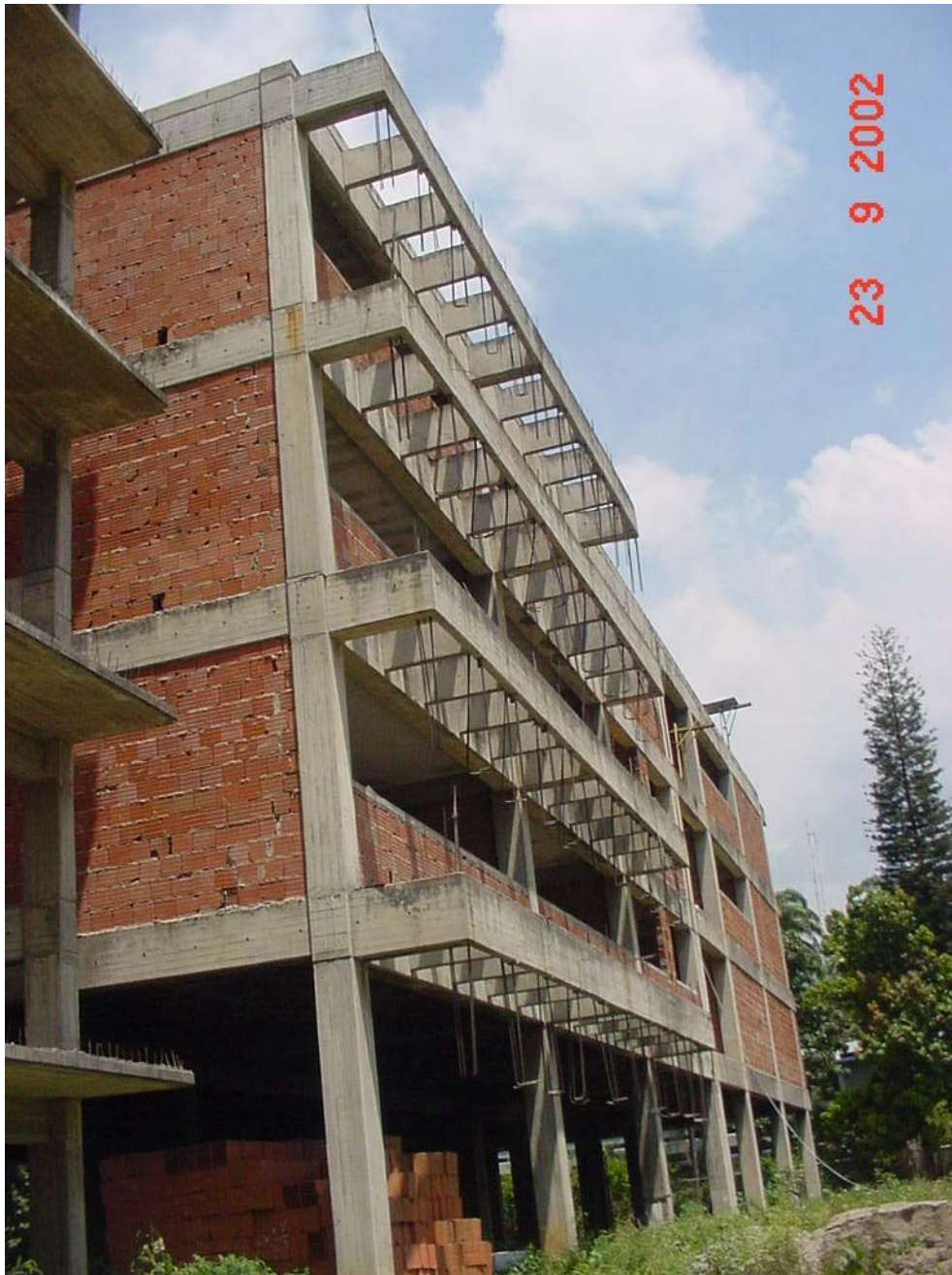
Fotografía VI.1: Fachada Este del Laboratorio Docente
