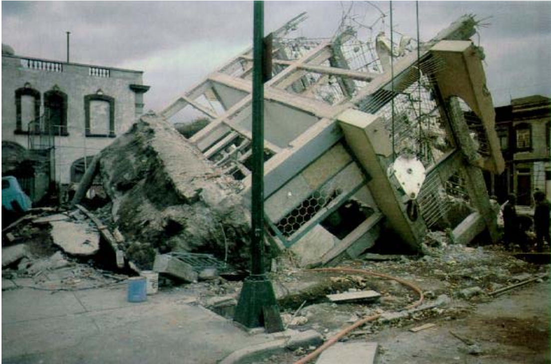
Fotografía IV.14: Colapso por Volcamiento ( http://www.ssn.unam.mx/SSN/Doc/Sismo85/Fotos/fl.htm )
