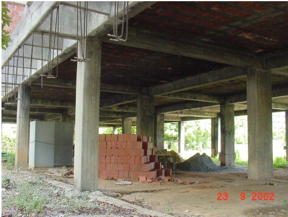
Fotografía VI.14: Pórtico 4 (Planta Baja)
