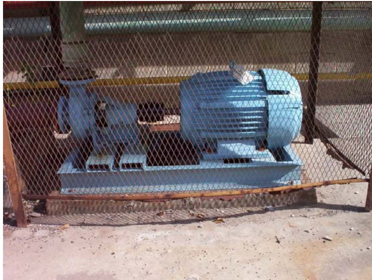
Figura 9.3.- Bomba de agua cruda después de realizado el mantenimiento correctivo
