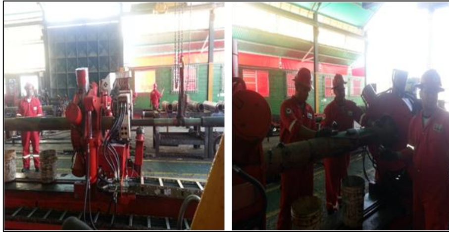
Figura II. 33. Desmontaje de aletas de AGS
