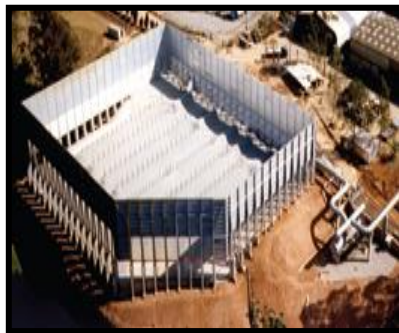
Figura II.12. Mechurrio a Nivel del Suelo Tipo LRGO (Flare LRGO Join Zink, 2004)
