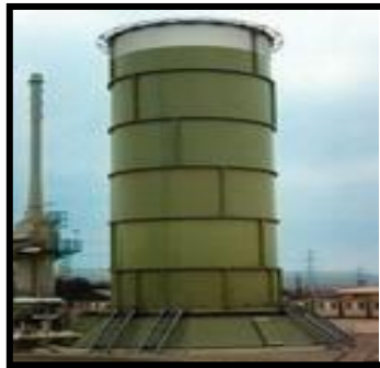
Figura II.11. Mechurrio a Nivel del Suelo Tipo KEGF (Flare KEGF Join Zink, 2004)
