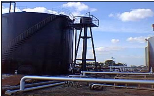
Es importante mencionar que el remanente de crudo extraído por medio del sistema de efluentes es reenviado por medio de bombas hacia los tanques de almacenamiento.
