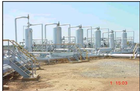
Figura N° 13: Separadores de Producción/ Prueba<sup>18</sup>
