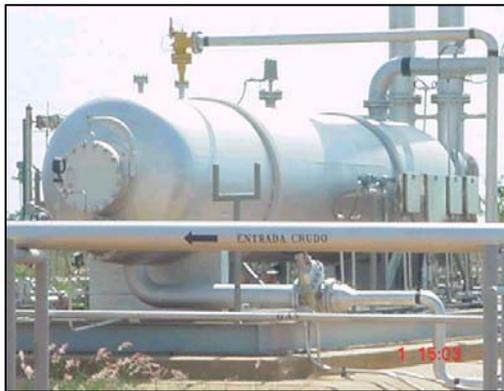
únicamente en las Estaciones de Flujo construidas en tierra y donde se opere con crudos que presenten ciertas características físicas y químicas (ver Anexo I) que justifiquen la instalación de un calentador
