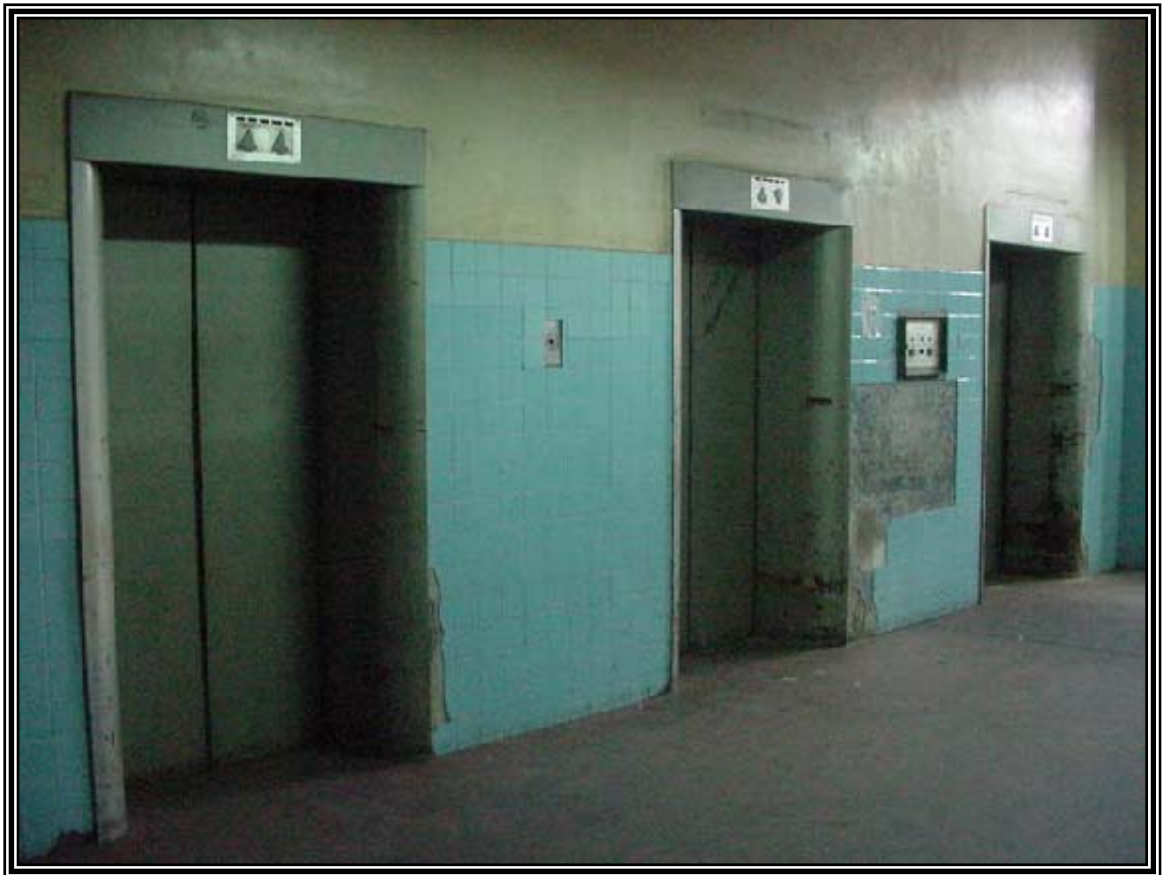
Figura 6. Puertas de pasillo (sótano) de ascensores 5, 6 y 7 (hospitalización).
