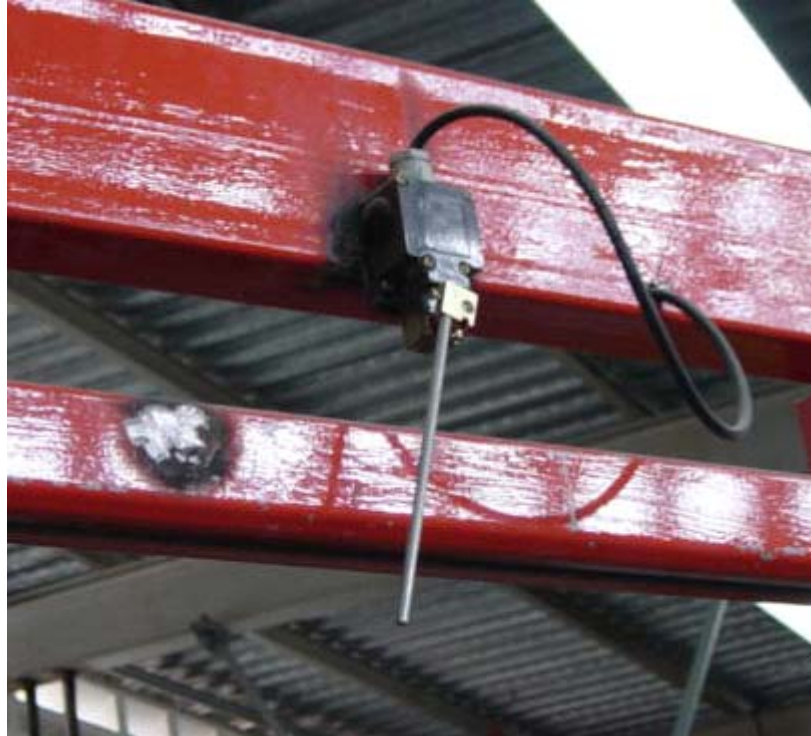
Figura 5.2.2. Microinterruptor para el cierre de la puerta de salida(Los autores)
