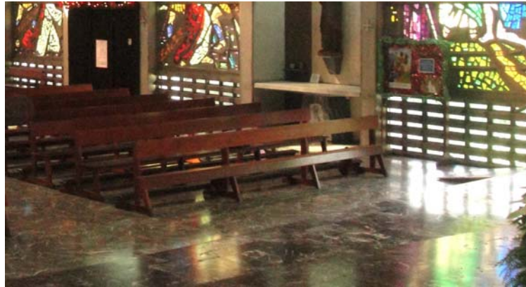
Ilustración N° 22 Interior del Templo Nacional San Juan Bosco, Caracas. Nótese los bloques huecos dispuestos para la entrada de aire.
