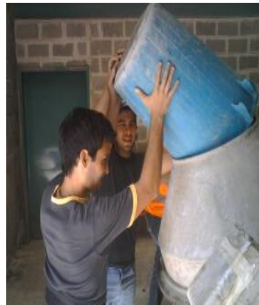
Figura 8. Incorporación de los materiales al trompo.
