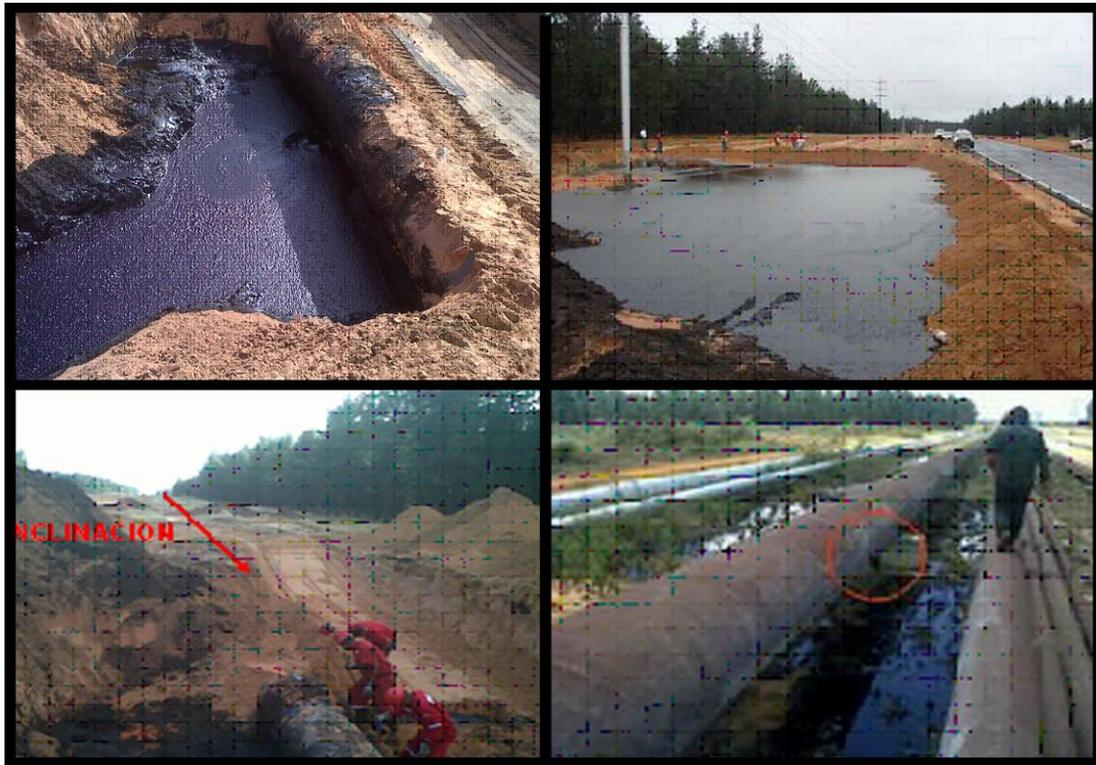
Figura 1.1. Consecuencias del colapso de línea de 36 pulgadas
