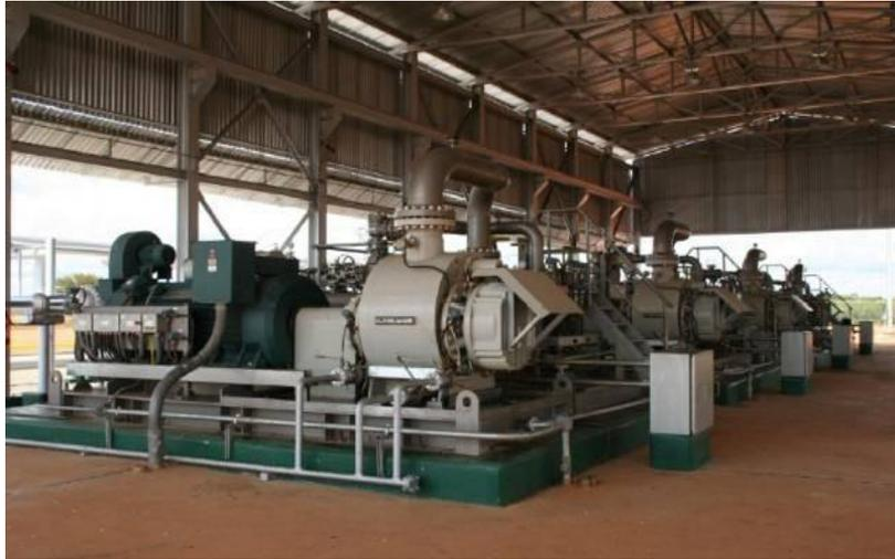
Figura 2.8. Bomba multifásica de doble tornillo.
