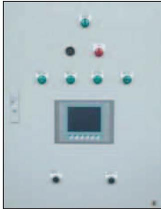
Figura 13. Aspecto externo de los tableros de control de dosificación de químicos
