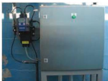
Figura 41. Tablero de adquisición de datos y turbidímetro de agua precipitada instalados.
