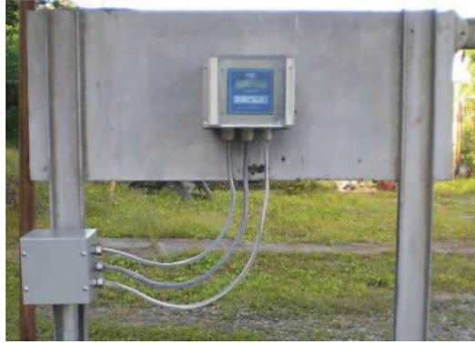
Figura 45. Panel de turbidímetro de agua cruda fijado en planta.
