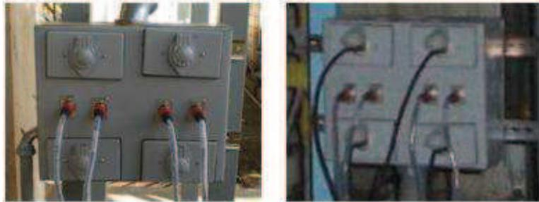
Figura 47. Cajas de conexión de las bombas de dosificación a los tableros de control.
