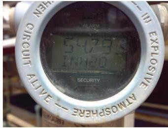
Figura 8. Panel indicador de los caudalímetros existentes.
