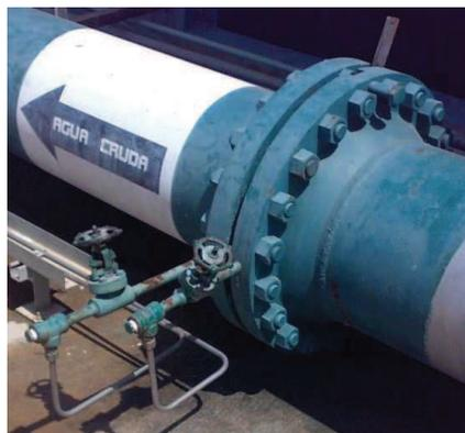
Figura 7. Brida utilizada para la medición de caudal por presión diferencial en la línea de proceso dirigida hacia los precipitadores 1, 2 y 3.
