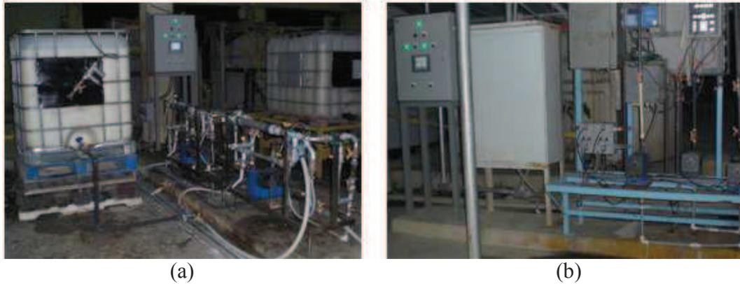
Figura 48. Tableros de dosificación energizados. (a) Tablero de dosificación de floculante energizado. (b) Tablero de dosificación de coagulante energizado.
