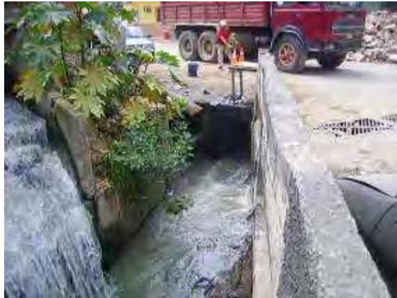
Fotos 5-36 y 5-37: Características del alcantarillado en Santa Cruz del Este. Municipio Baruta. En la esquina de las calles Unión y Los Mangos la topografía presenta un punto bajo donde confluyen todos los aportes de aguas residuales y de lluvia. Este punto se ha desbordado varias veces y hace muy vulnerable al barrio a la amenaza por inundación.
