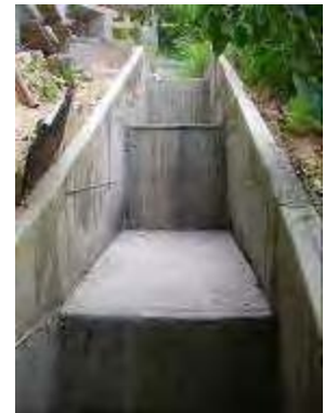
Fotos 5-27, 5-28 y 5-29: Características del alcantarillado en Las Minas de Baruta. Municipio Baruta, Caracas. Puede observarse que parte del sector cuenta con colectores con bocas de visita, sumideros de rejilla y torrenteras.
