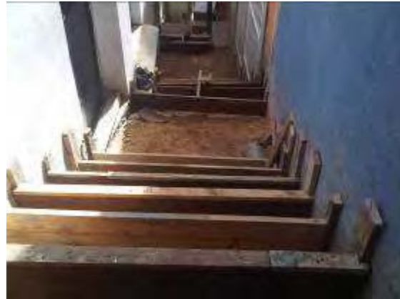
Fotos 5-8 y 5-9: Construcción de acueducto y alcantarillado condonacional en el sector La Palomera, municipio Baruta. Estado Miranda. Construcción de peldaños para las nuevas escaleras.
