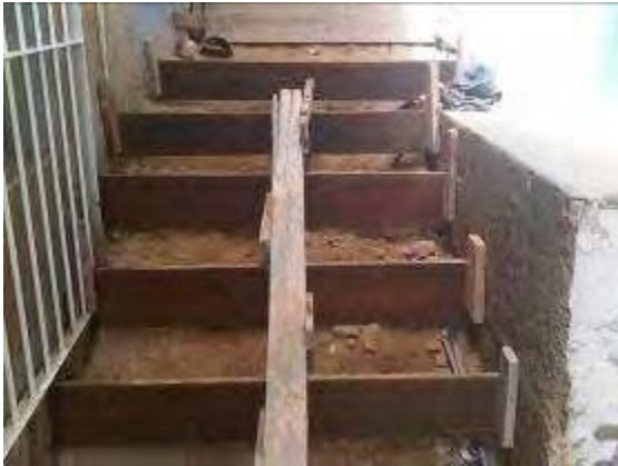
Fotos 5-8 y 5-9: Construcción de acueducto y alcantarillado condonacional en el sector La Palomera, municipio Baruta. Estado Miranda. Construcción de peldaños para las nuevas escaleras.
