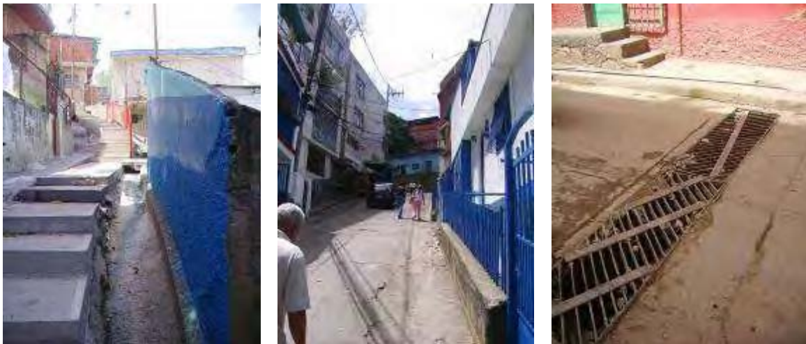
Fotos 5-33, 5-34 y 5-35: Características del alcantarillado en Santa Cruz del Este. Municipio Baruta. Las imágenes corresponden a diversos elementos del drenaje de aguas pluviales: escaleras con canaletas bien construidas, calles con fuertes pendientes y sumideros de reja en calzada de concreto.
