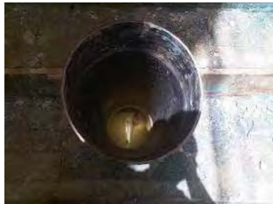
Fotos 5-10 y 5-11: Construcción de acueducto y alcantarillado condonacional en el sector La Palomera, municipio Baruta. Estado Miranda. Construcción de boca de inspección para el alcantarillado. Será culminado mediante una tapa de registro de concreto.
