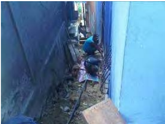
Foto 5-6: Construcción de acueducto y alcantarillado condonial en el sector La Palomera, municipio Baruta. Estado Miranda. Se puede apreciar la demolición de un tramo corto y el uso de herramientas manuales.
