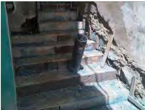
Fotos 5-10 y 5-11: Construcción de acueducto y alcantarillado condonacional en el sector La Palomera, municipio Baruta. Estado Miranda. Construcción de boca de inspección para el alcantarillado. Será culminado mediante una tapa de registro de concreto.
