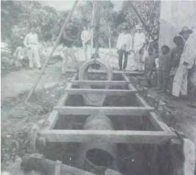
**Foto 4-9:** Construcción de un colector de sección ovoidal en el sector la Esmeralda de Caracas hacia 1928.
