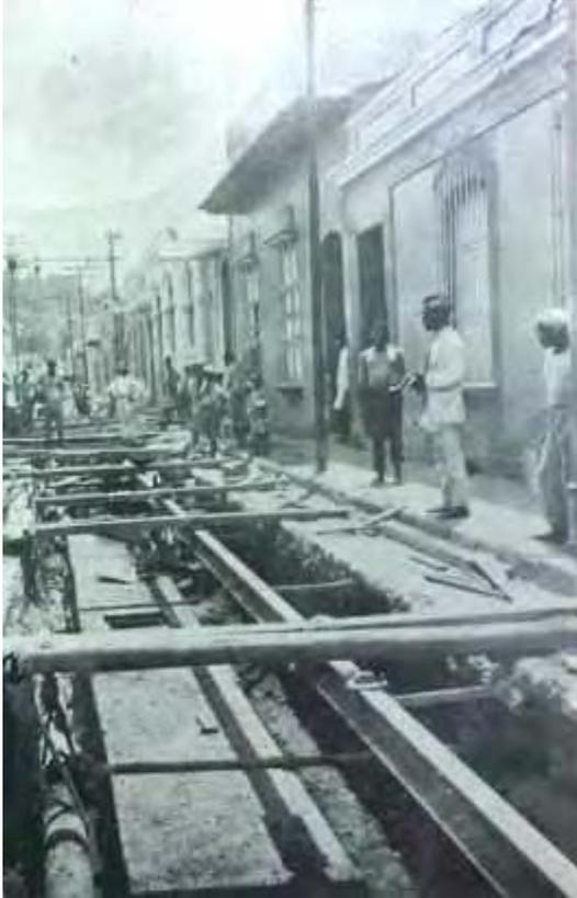
**Foto 4-11:** Construcción del colector de la Hoya Luzón (Los Padrones), entre las esquinas de Pepe Alemán y Las Delicias.
