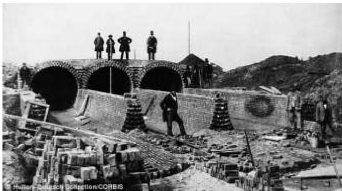
Foto 3-9: detalle de la construcción del colector emisario del norte (Northern Outfall Sewer), aguas abajo de la estación de Bombeo de Abbey Mills, una de las obras de alcantarillado propuesta por Joseph Bazalgette
