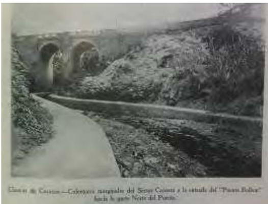
**Foto 4-12:** Colectores marginales de la quebrada Caroata, a la entrada del puente Bolívar, hacia la parte Norte del Puente.
