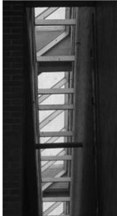
Figura 96. Estructura del techo
