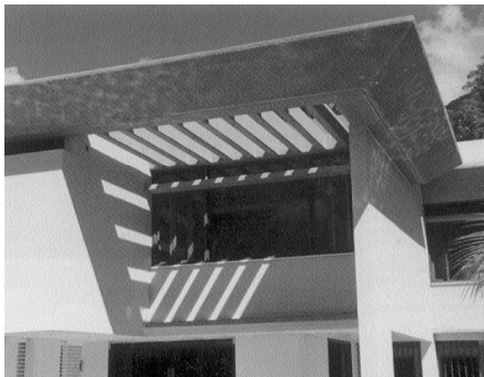
Figura 50 Utilización del techo como protección solar de la envolvente
