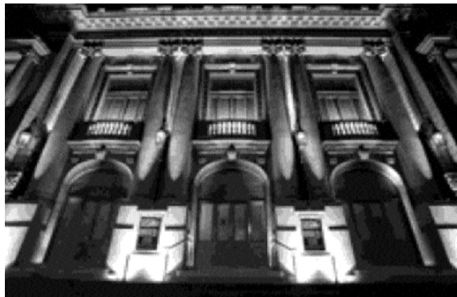
Figura 114 Reflectores exteriores para iluminación exterior de las edificaciones. Iluminación Monumental
