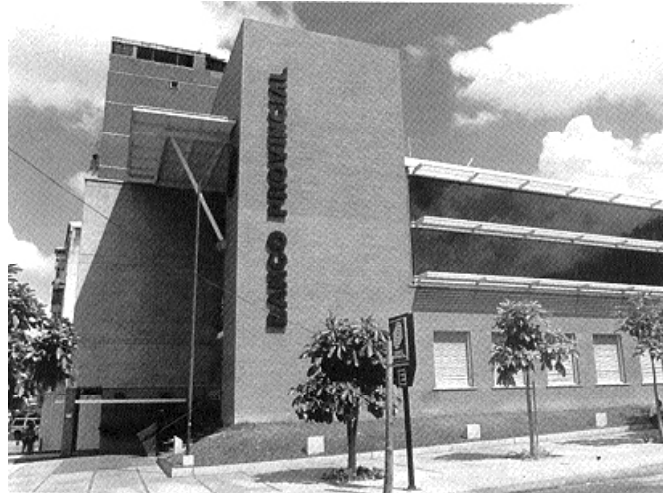
Figura 51 Techos a diferentes alturas para producir sombras propias Fuente: Revista Entre Rayas, No. 26, Sep. 98. Edificio Banco Provincial La Florida. Arq. Juan Carlos Parilli.
