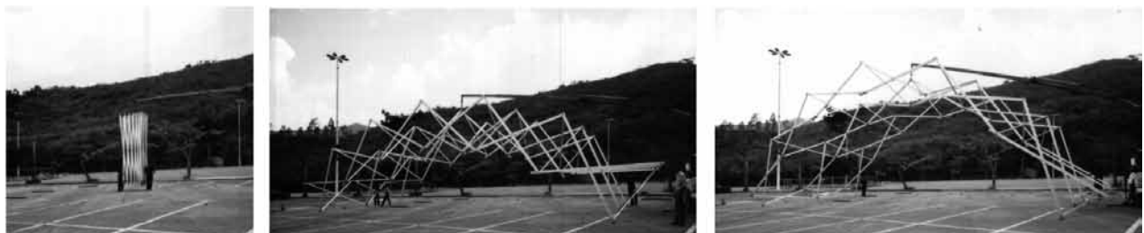
Figura 5 Proceso de despliegue
