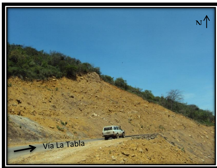
Figura 18. Fotografía de un derrumbe de la Formación Patiecitos. Tomada por Andreina Fernández
