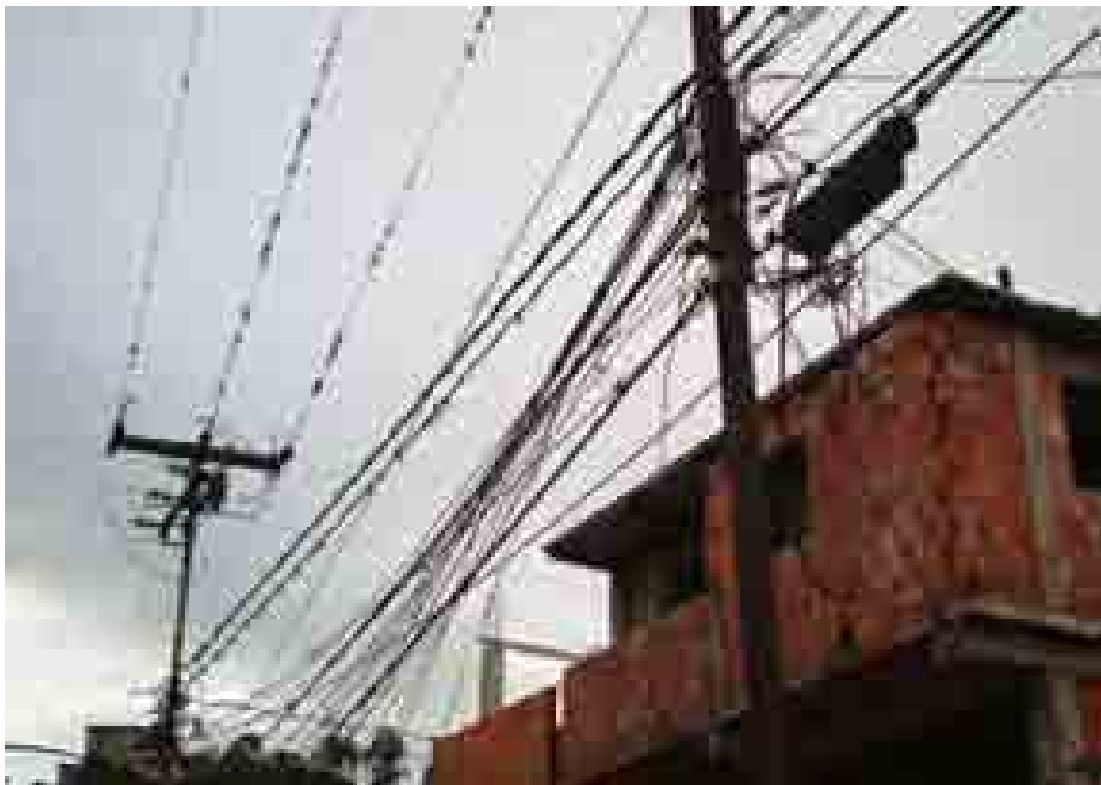
Imagen N° 42 y N° 43: los tendidos eléctricos del barrio dispuestos en forma desordenada. Fuente: archivo fotográfico: Arq. M. M. Oramas, 2011.
