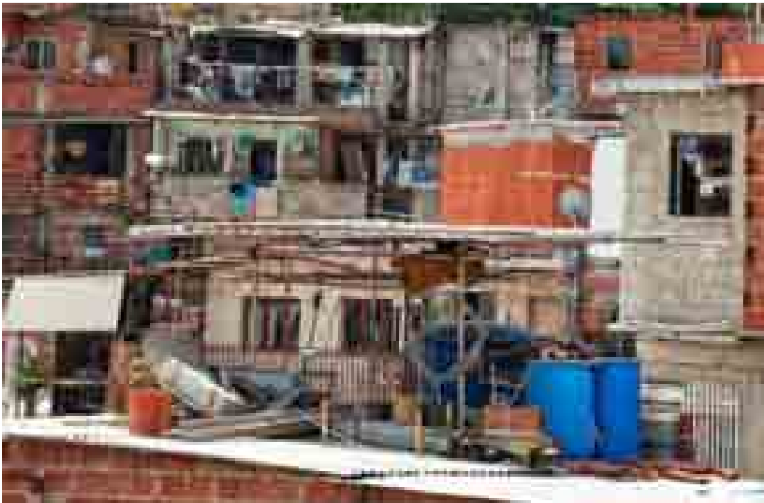
Imagen N° 59: la gran cantidad de materiales de construcción dispuestos en los techos de las viviendas Archivo fotográfico: Arq. M. M .Oramas, 2011.
