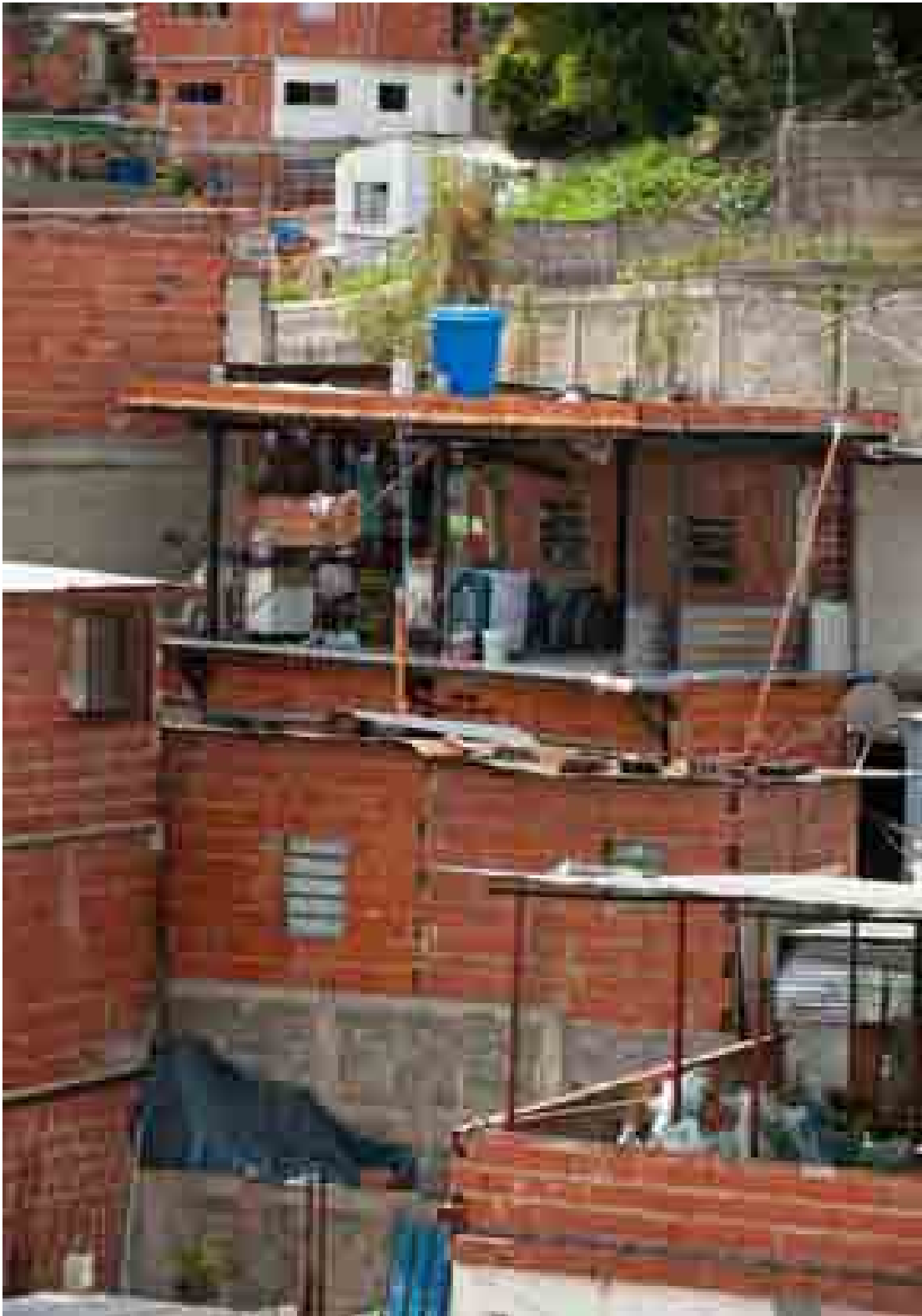
Imagen N°53: en la imagen se observa los tanques de agua prefabricados en las viviendas del barrio El Placer de María. .Archivo fotográfico: Arq. M. M .Oramas, 2011.
