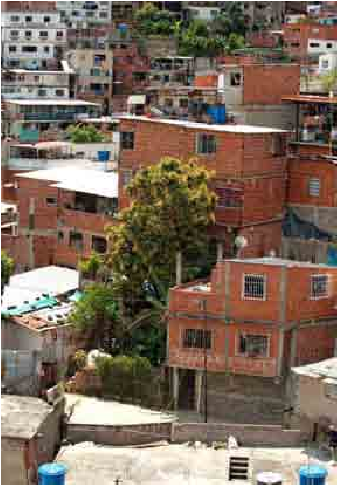
Imagen N°55 En el paisaje del barrio se observa gran cantidad de viviendas construidas con ladrillos o bloques de arcilla sin revestir. Archivo fotográfico: Arq. M.M.Oramas, 2011.
