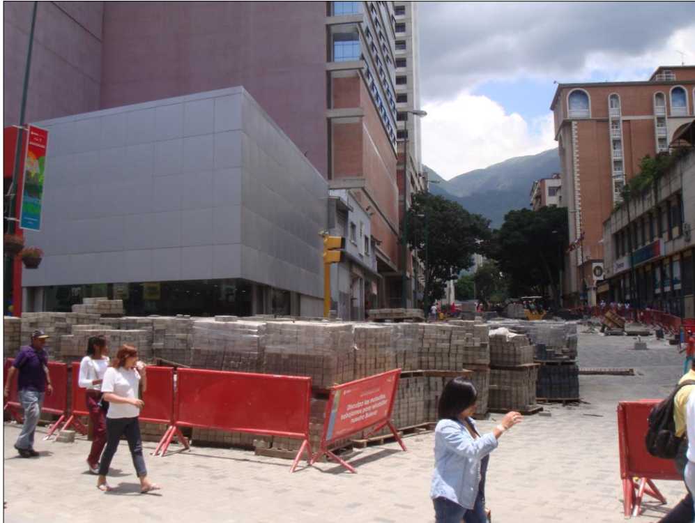
Imagen 31: Trabajos de Rehabilitación en el Boulevard de Sabana Grande Fuente: Propia 2011
