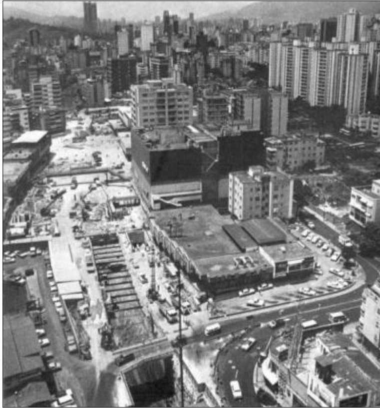
Imagen 14: Construcción de la Estación Chacaíto inicio de los años 80 Fuente: SabanaGrandeOnline, 2011
