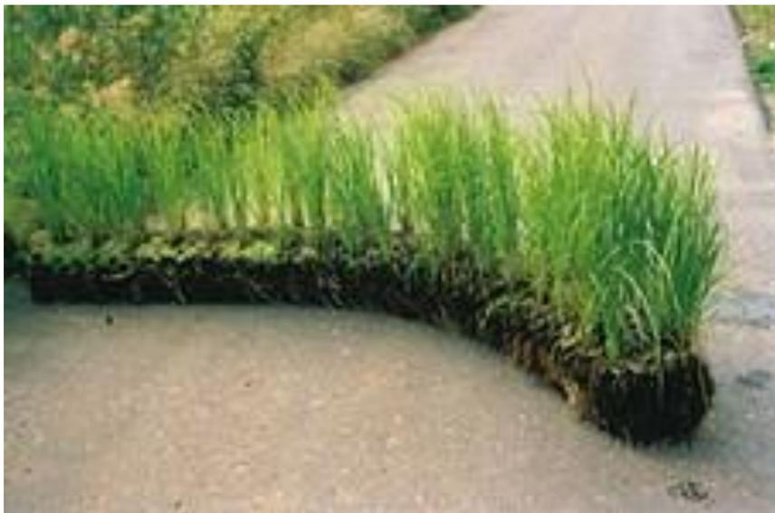
Utilización de biorrollos para control de erosión
