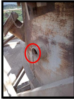
**Figura N°41** Entrada de los gases a la T.A.G
