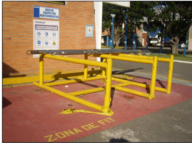
Fig. III.13b: rack de FIT .
