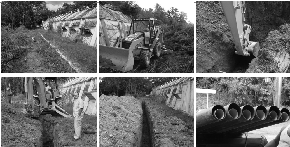
Foto 2 Excavación de la zanja de 2 m. de profundidad y 30 m. de largo. Tubos PVC de Ø 4" y 6"
