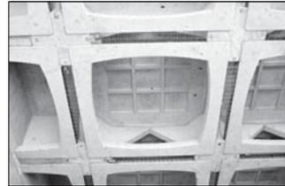
El plano inferior de la losa quedó conformado por una serie de marcos rígidos, de dimensiones nominales acordes con la retícula de 3 m x 3 m y entre los cuales se alojaron dos juegos de cables de alta resistencia en las dos direcciones ortogonales. Este conjunto es el responsable de absorber la tracción que deriva de la flexión de la losa: los marcos como elementos que proporcionan la rigidez y los cables absorbiendo el gran esfuerzo de tensión (foto 20).
