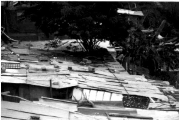
láminas además de la mala calidad y su poca resistencia están propensas a tener puntos vulnerables a la rotura y filtraciones, al cabo de muy poco tiempo. Para este caso, la cumbrea debe contener en su diseño el enlace correcto entre las dos pendientes del techo y contener un detalle separador de la misma con la cobertura para evitar la entrada del agua por capilaridad.
