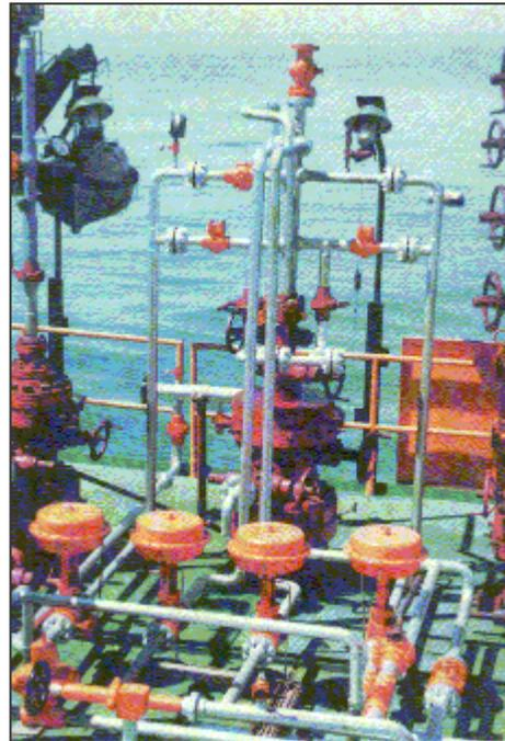
II.4.- Cabezal Pig Lift en una Plataforma
