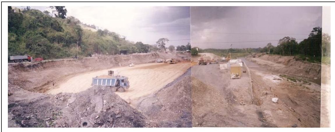
Figura 33. Fotocomposición vista hacia el Este, de trabajos de remoción de material en Puente hacia Aragüita.
