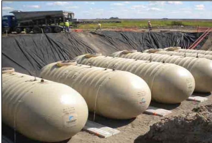
**Figura N°2.**Arreglo de varios tanques de Fibra de Vidrio.
