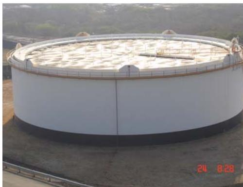
**Figura N°5.** Tanque de Acero Convencionales (Techo Flotante).
