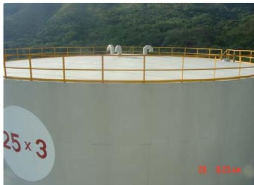
**Figura N°4.** Tanque de Acero Convencionales (Techo Fijo).
