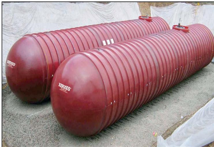
**Figura N°3.** Arreglo de dos tanques de Fibra de Vidrio.
