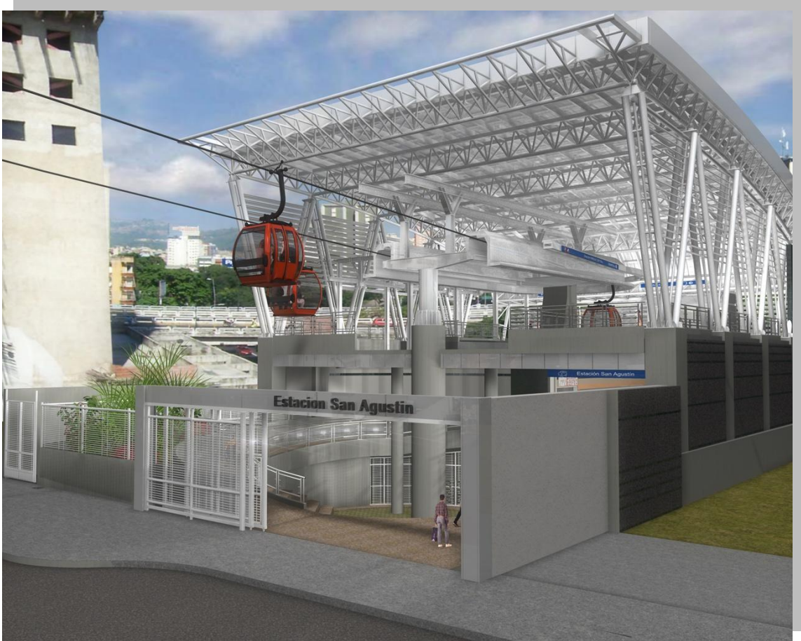
Tomado del Proyecto del Metrocable 2007.
