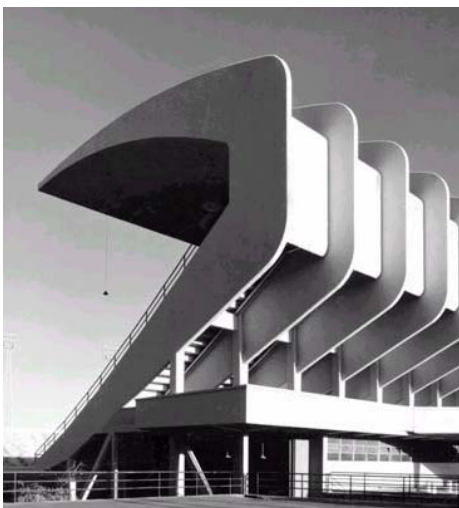
Figura N° 8: Valorización del concreto a la vista
