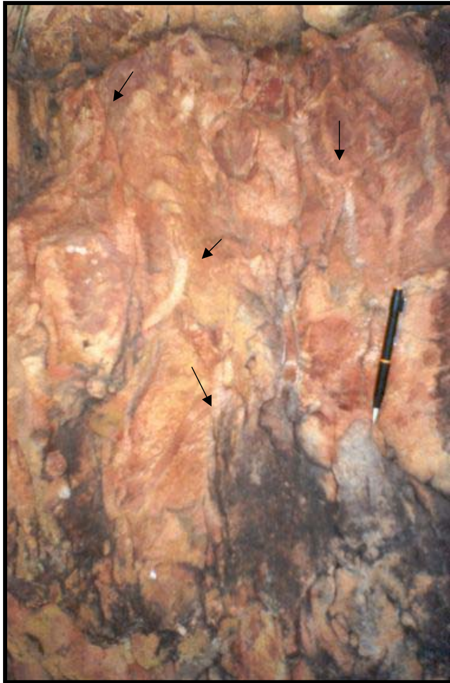
Figura 5.7: Detalle en estrato ubicado en el tope de la sección levantada en la carretera Urica - antenas repetidoras, mostrando los colores de meteorización típicos de estas rocas y las horadaciones mayormente verticales presentes en ella. Rumbo de la foto S 55° E .
