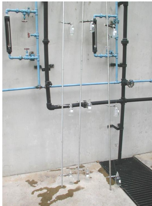
Figura N ° 9. Sistema para la captación de muestras diseñados en la Planta de tratamiento.
