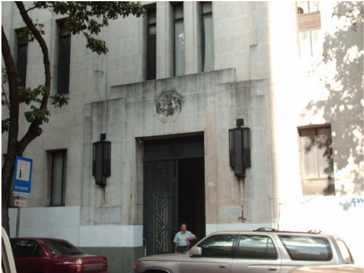
Foto N° 1. Fachada de la Biblioteca Pública Central “Simón Rodríguez”
