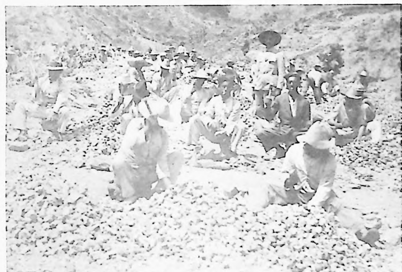
Trabajadores de la carretera trasandina picando piedra con martillo para hacer granzón y cubrir la carretera; no se utilizó maquinaria, solamente dinamita para abrir algunos tramos.
