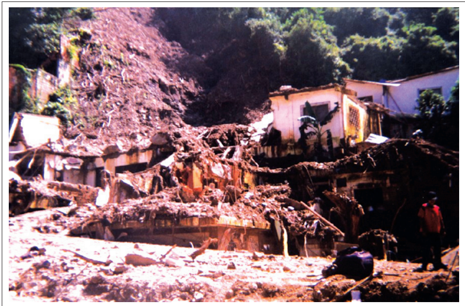
Figura 10. Fotografía del desizamiento ocurrido el 16 de diciembre en la zona de La Veguita (Macuto), el cual produjera la muerte de varias personas refugiadas en la casa que se aprecia destruida. Escenas y hechos como este contribuyeron a la elaboración del discurso sobre la tragedia: aludes repentinos, oleajes gigantesos y muertes colectivas, favorecieron la idea del mayor desastre de la historia . Fotografía tomada por un habitante de la zona a pocos días del hecho y cedida gentilmente a los autores
