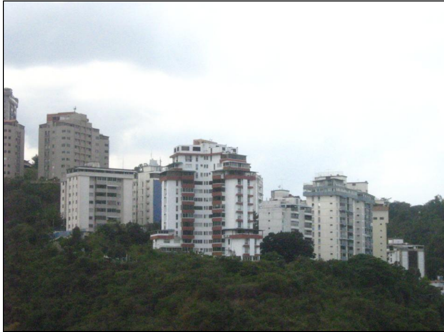
Foto 8. Caracas. Taludes remanentes, Urb. Colinas Bello Monte
