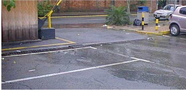
**Figura N°23 :** Sumideros de reja colocados linealmente, estacionamiento Consulta Externa.
