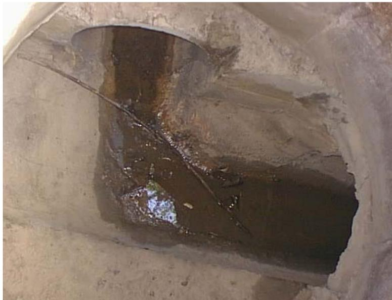
**Figura N°27 :** Base de concreto sin armar para bocas de visita.
