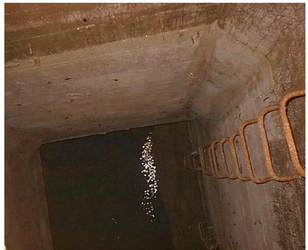
**Figura N°29 :** *Izq.* Salida de descarga sobre colector marginal Izquierdo Valle; *Der.* Escalera de acceso al Río Valle.
