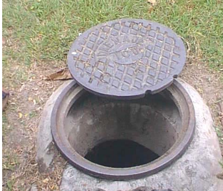
Figura N°5 : Marco y tapa tipo liviano para bocas de visita, Facultad de Ingeniería, U.C.V.
