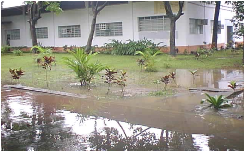
Figura N°6 : Zona de estancamiento, pasillos techados, Facultad de Ingeniería U.C.V.
