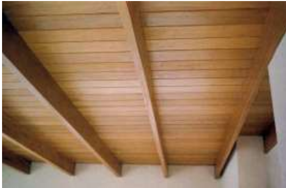
Fig. 61 Techo de Machihembrado de madera
