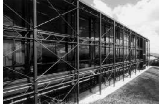
Fig. 10: Arriostramientos del Instituto de Ingeniería
