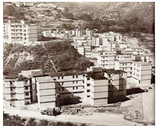
Construcción de la Ciudad Vecinal Caricuao, en Caracas (1965)
