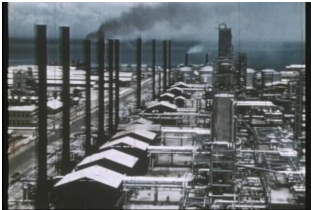
Oleoducto (1952). Refinería de Cardón.
