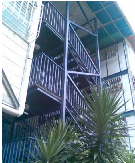
Imagen 9. Vista núcleo de escaleras. Urb. La Esperanza. Casalta.
