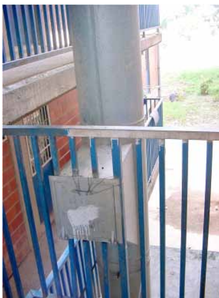
Imagen 14. Ductos de basura clausurados con alambres. Urb. Mata de Coco. Valles del Tuy, estado Miranda.
