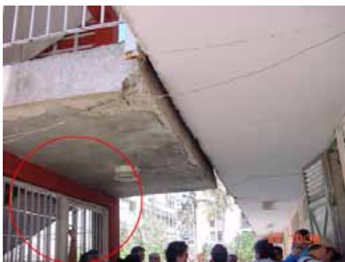
Imagen 23. Cierre de entrada a la edificación a partir de las escaleras de circulación, Urb. Vicente Emilio Sojo, Guarenas, estado Miranda.
