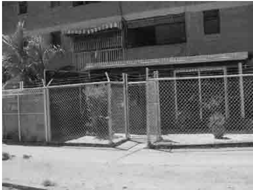
Foto 4 Refacciones en las fachadas de los edificios
