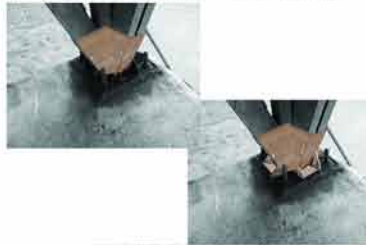
COLOCACIÓN DE PLANTAS DE ACERO PARA EL REFORZO DE LAS BASES
