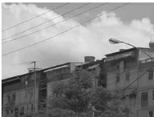
Foto 6 Se puede observar crecimientos en los apartamentos superiores.
