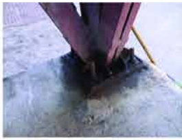
BASE ESTRUCTURAL (ACTUAL) DE UNO DE LOS EDIFICIOS DE CASALTA (SECTOR LA ESPERANZA)
