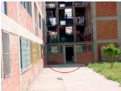
Imagen 22. Cierre de entrada a la edificación, Urb. Mata de Coco, Valles del Tuy, estado Miranda.
