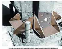
COLOCACIÓN DE PLANTAS DE ACERO PARA EL REFORZO DE LAS BASES
