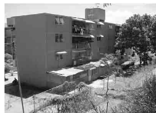
Foto 7 Crecimientos o ampliaciones en las plantas bajas de la edificación.
