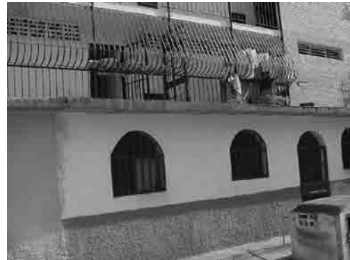
Foto 5 Crecimientos informales en la planta baja de la unidad multifamiliar.
