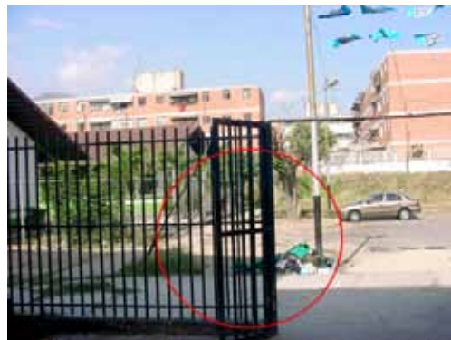
Imagen 24. Cierre de entrada a la edificación a partir del retiro con la calle, Urb. Las Mercedes, La Victoria, estado Aragua.
