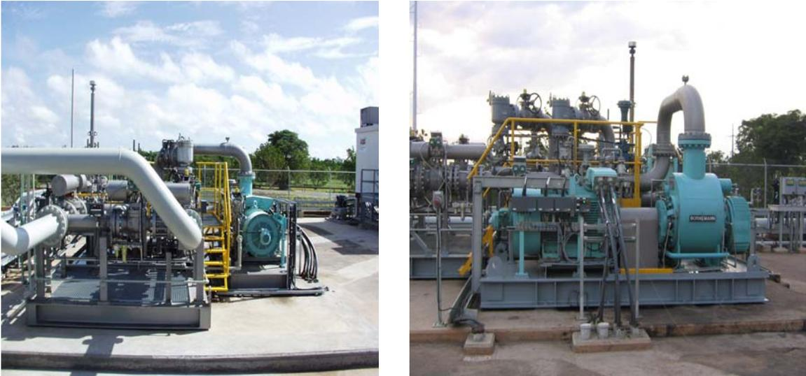
**Figura 16 Bomba Multifásica, vista frontal y lateral.**
