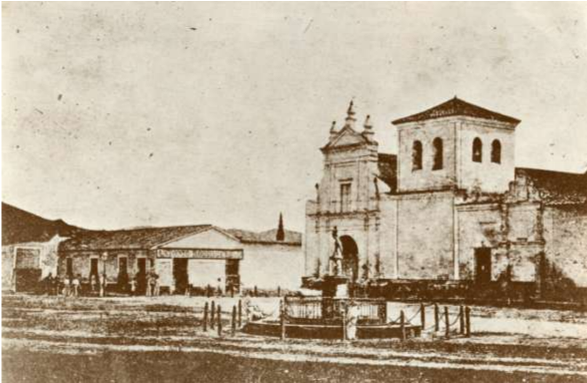
Figura N° 30. Iglesia San Pablo
