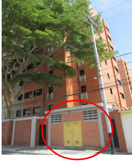
**Figura 34.** Caseta de transformación superpuesta que contiene un Banco de Transformadores Monofásicos en una Edificación Residencial Multifamiliar. Carrera 23 entre 9 y 10, Barquisimeto.
