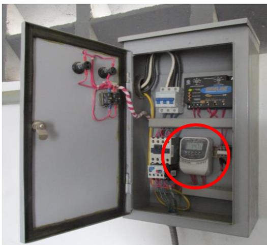
**Figura 9:** Tablero automático para control de riego con interruptor horario.
