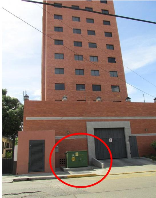
**Figura 32** Transformación tipo Pedestal Trifásico en una Edificación Residencial Multifamiliar. Calle 8 entre carreras 27 y 28, Barquisimeto.
