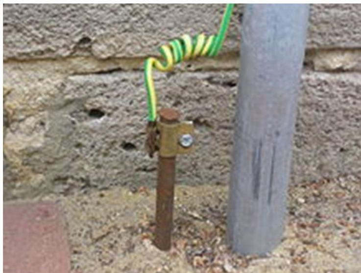
**Figura 29.** Electrodo de puesta a tierra y su conexión.
