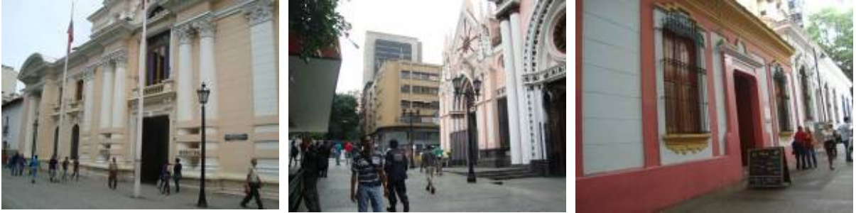
Fotos N° 25, 26, 27, 28, 29, 30, 31, 32, 33 Edificaciones patrimoniales en las adyacencias Fuente: Márquez, 2017
