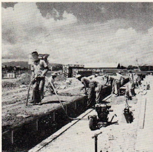
Vaciado de losas pretensadas en moldes metálicos. El concreto se transporta por camión mezcladora
