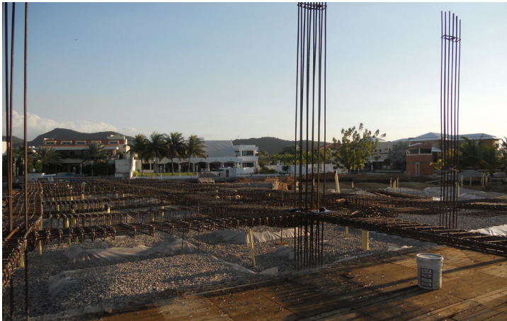
(1) Vigas de la losa de fundación o "losa flotante".
