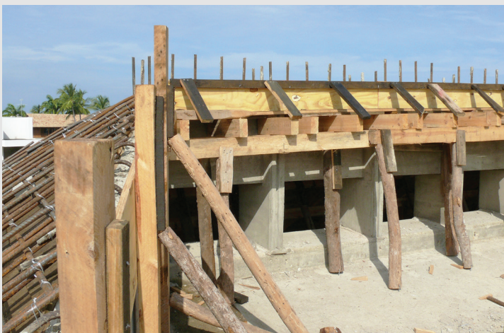
(7) Foto parasoles estructurales en obra, Casa de la Abuela.
