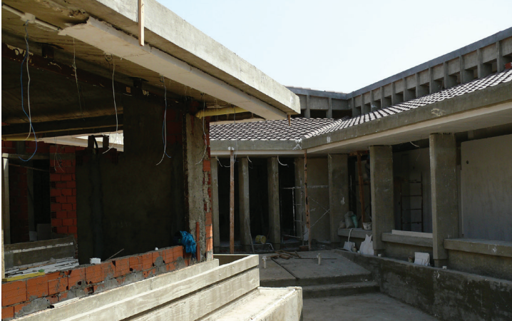
(19) Montaje de "parasoles estructurales"
