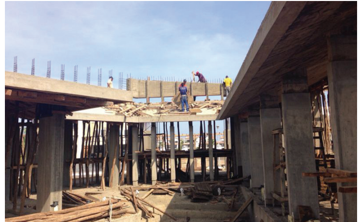
(8) Montaje de "parasoles estructurales".
