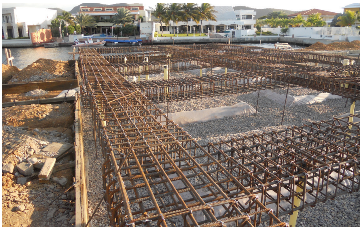
(3) Armado de las Vigas de la losa de fundación o "losa flotante".
