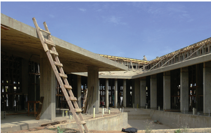
(9) Primeras perspectivas de la piscina en obra.
