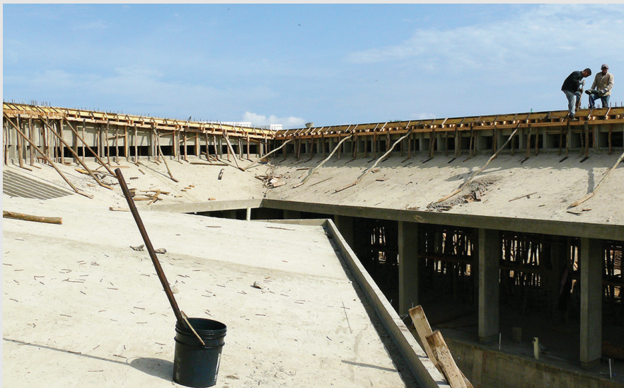
(2) Fotografía de parasoles estructurales en obra, Casa de la Abuela
