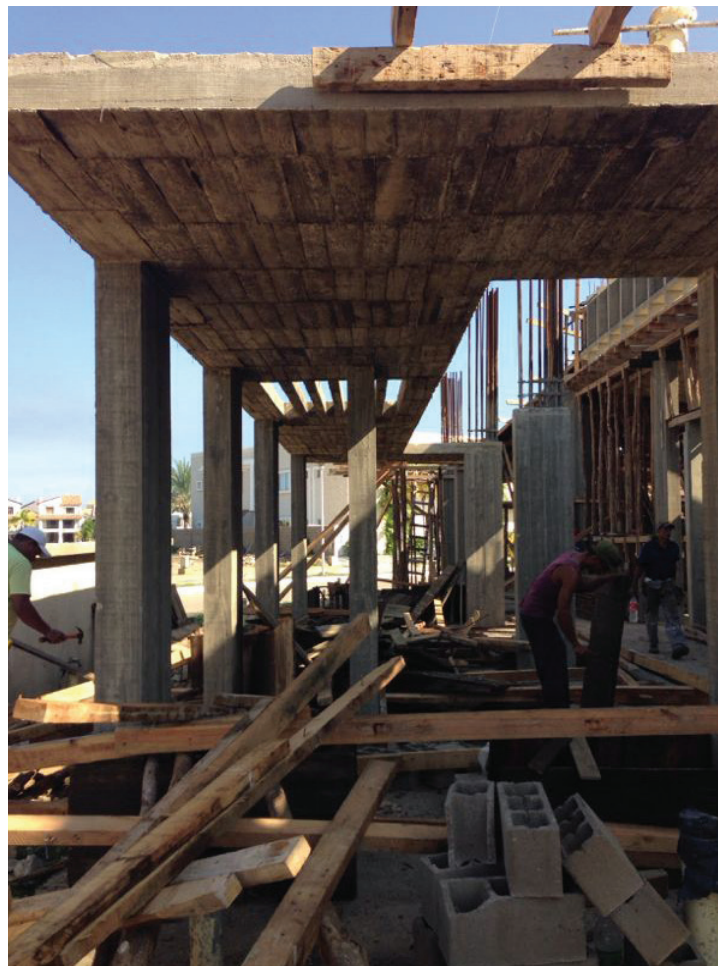
(14) Cubierta del volumen de servicios y encofrado de la cubierta.
