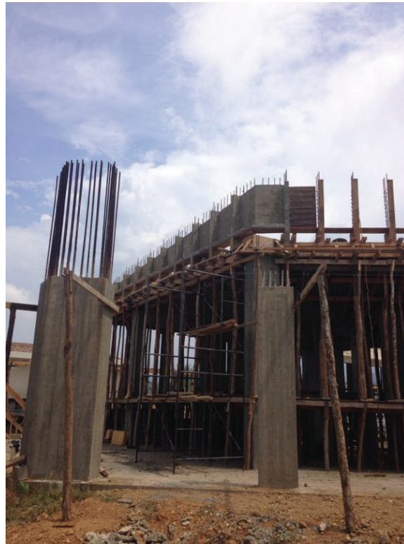
(4) Montaje de los "parasoles estructurales"
