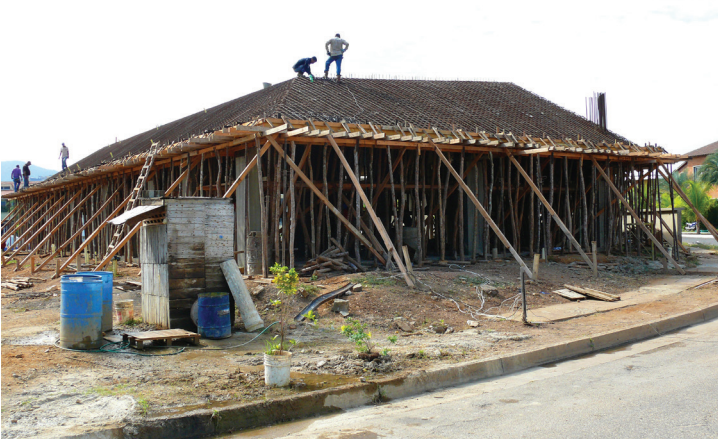
(21) Armado de la losa maciza de la cubierta.
