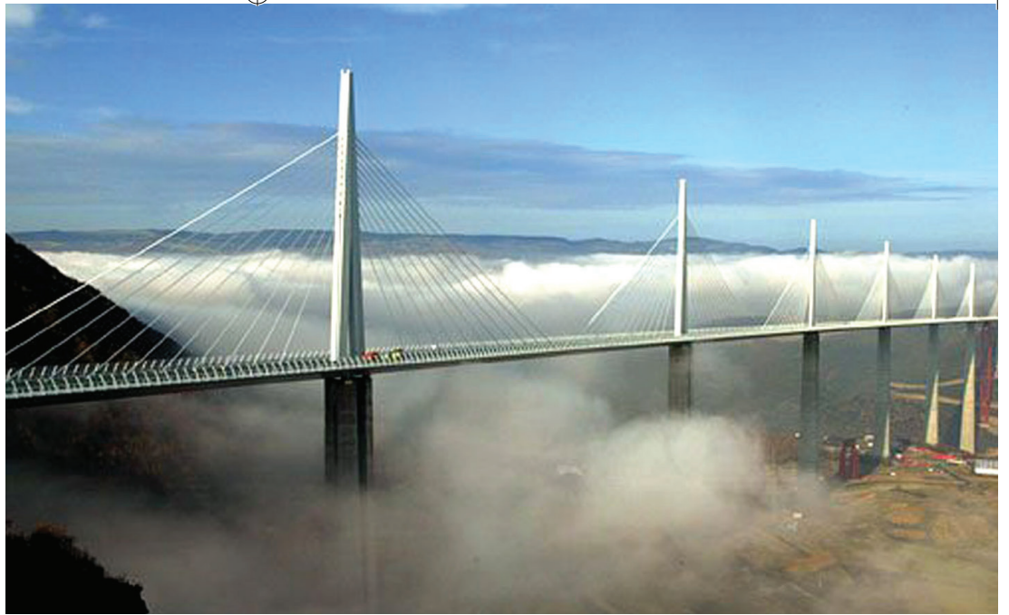
(1) Viaducto de Millau, Norman Foster, Aveyron, 2004.
