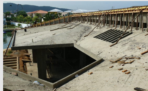
(4) Vista desde la cubierta, Casa de la Abuela.
