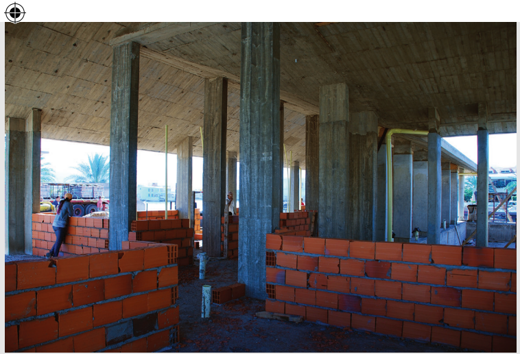
(5) Foto corredor de dormitorios en obra, Casa de la Abuela.
