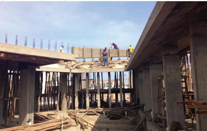
(21) Armado de la losa maciza de la cubierta.
