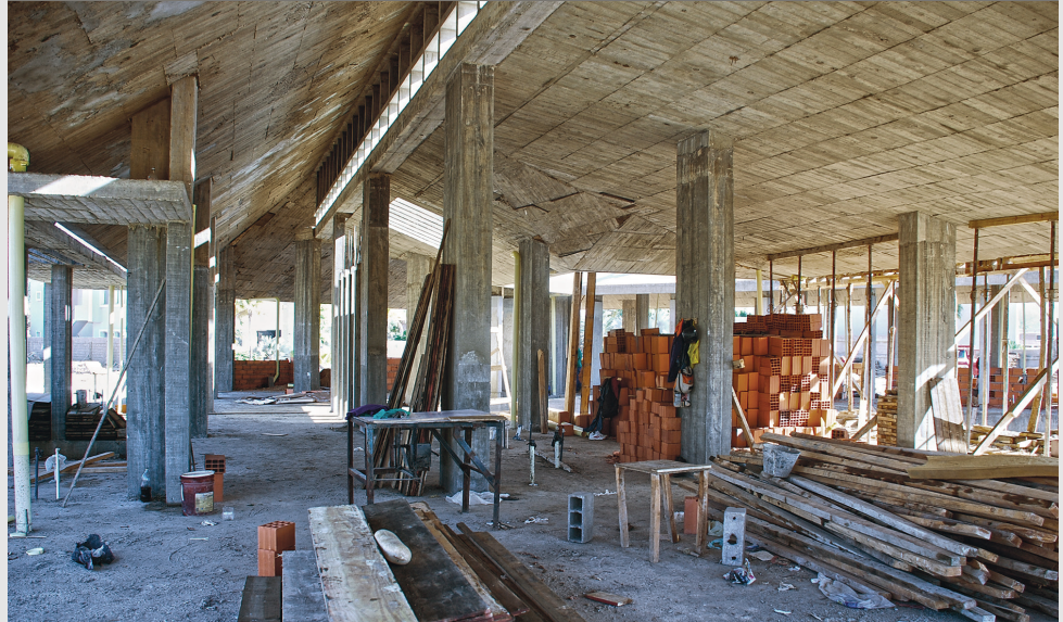
(1) Al interior de la obra. Estructura y techos de concreto armado, Casa de la Abuela, 2014
